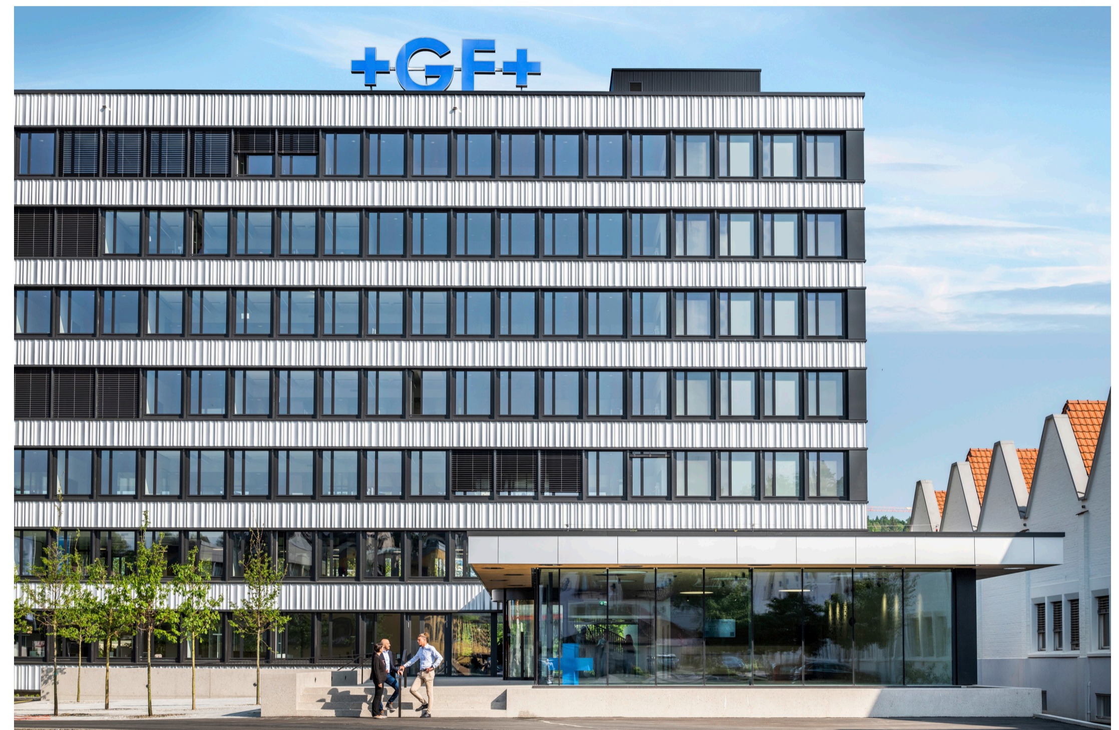
Der Konzernhauptsitz von GF in Schaffhausen wurde innerhalb eines Jahres vollständig modernisiert. Entstanden ist ein modernes, nachhaltiges Gebäude, das zukunftsorientierte Arbeitsplätze bietet. BILD ZVG/GF
