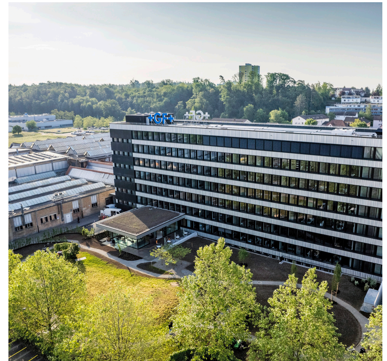
Der Empfangsbereich auf der Vorderseite des Gebäudes findet seine Entsprechung auf der Rückseite. Dort lädt ein von Bäumen gesäumter Garten zur Begegnung und zum Austausch ein. Die Sträucher und Blumenwiesen bieten Lebensraum für Insekten.
