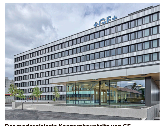
Der modernisierte Konzernhauptsz von GF.
