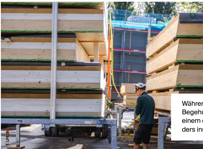
Mit einem Kran werden grosse Dachelemente auf das Gebäude gehoben.
