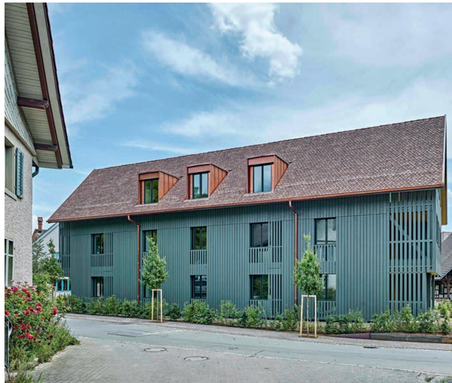
Eine graue Öllasur deckt die Holzfassade und integriert das Gebäude auch farblich in den Dorfkern.
