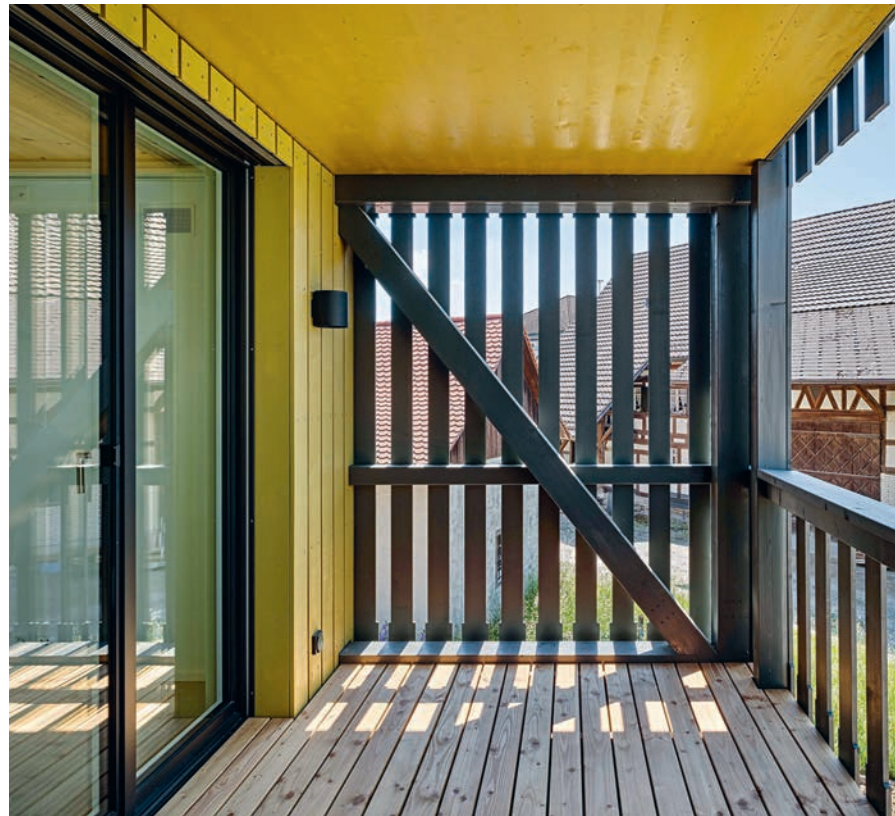
Knallgelbe Untersichten verleihen dem Baukörper im historischen Dorfkern eine erfrischende Identität.
